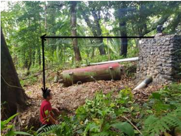
Gambar 2. Head setinggi 3 meter
